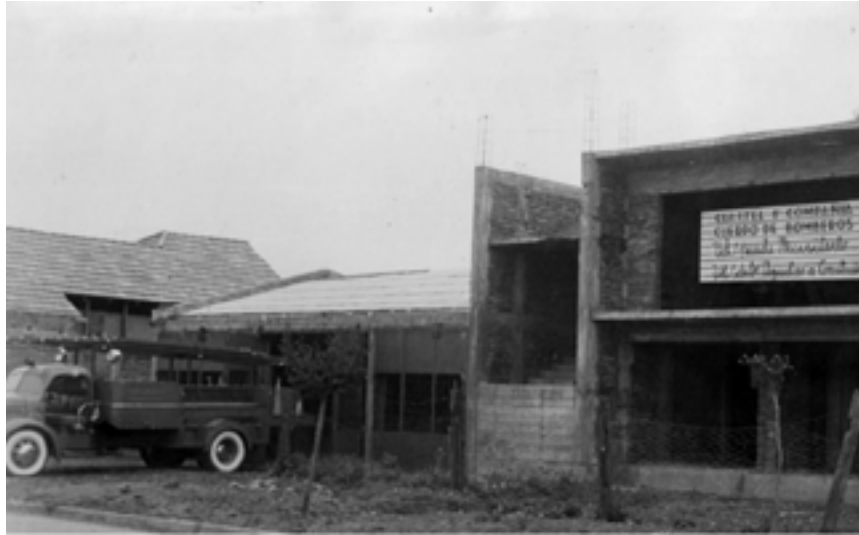
Construcción del edificio del Cuerpo de Bomberos en la década de los años 50. Su inauguración fue el año 1965. Aparece el primer carro llamado "La Peta".
