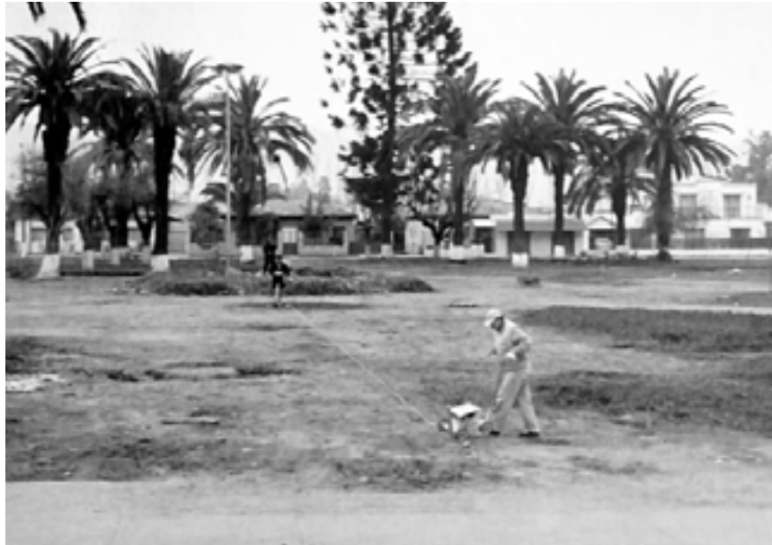
Los años 90. Cuando empezaron los trabajos de la remodelación de la actual plaza de armas.
