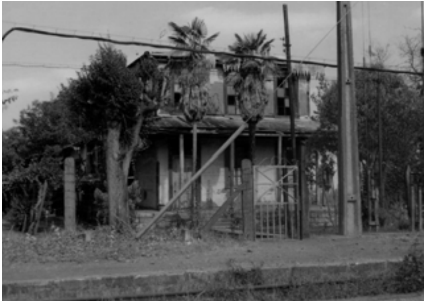
Lo que fue por muchos años una atracción arquitectónica y residencia de los jefes de estación de Chimbarongo en el esplendor de los Ferrocarriles del Estado.
