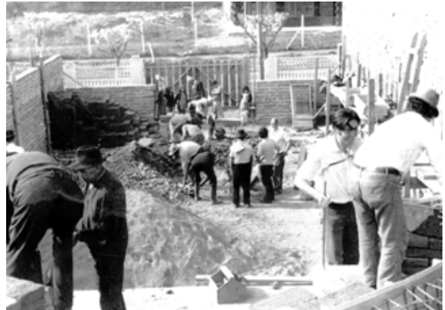
Construcción del Templo Evangélico terminando los años 60. Ubicado en la calle Blanco Encalada a un costado del gimnasio del Club de Deportes.
